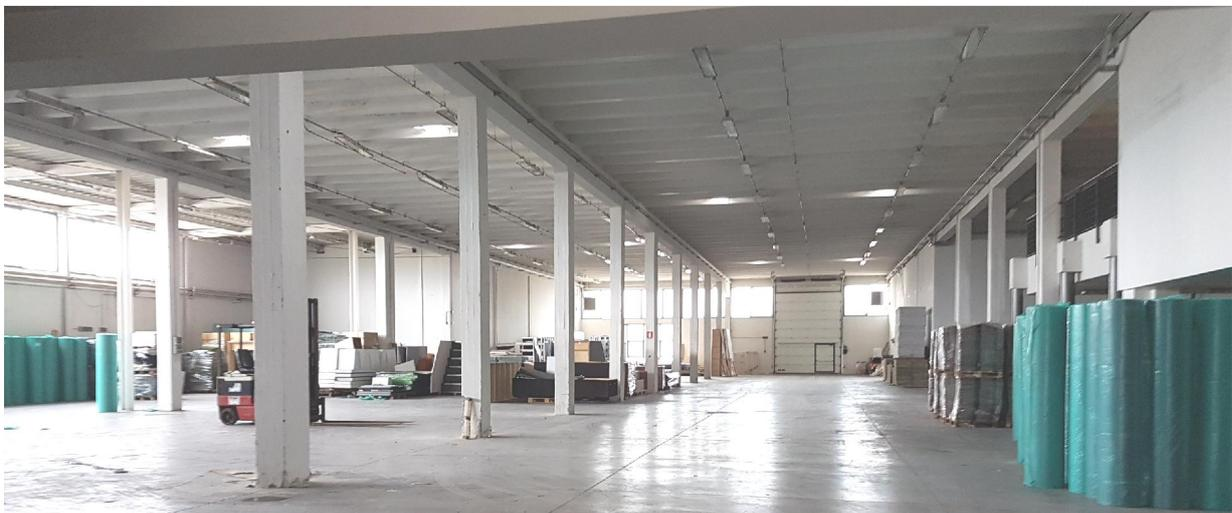
L'interno del capannone: notare la selva di pilastri e la struttura di copertura semplicemente appoggiata
